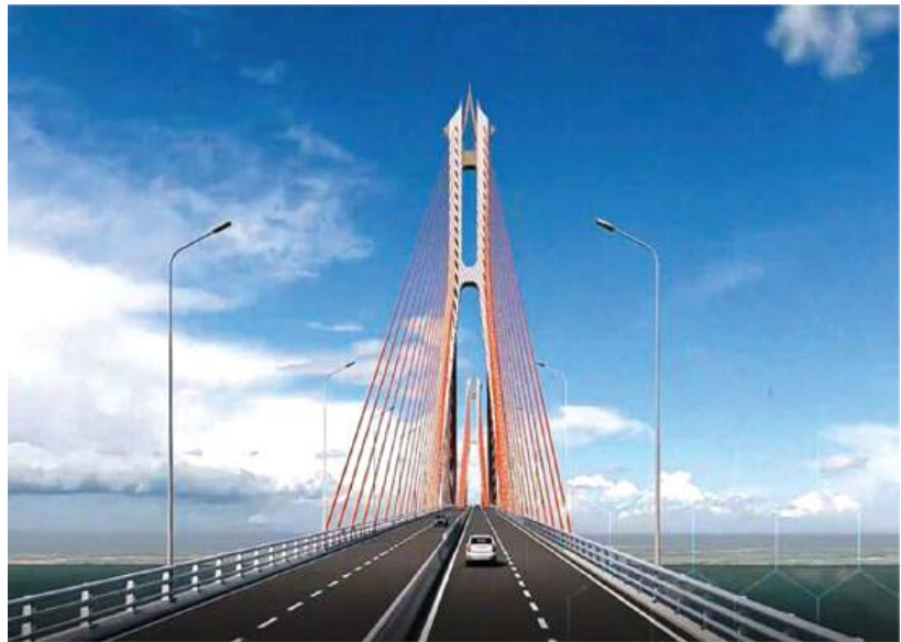
Phối cảnh cầu Đại Ngãi bắc qua sông Hậu Perspective of Dai Ngai bridge spanning Hau river
